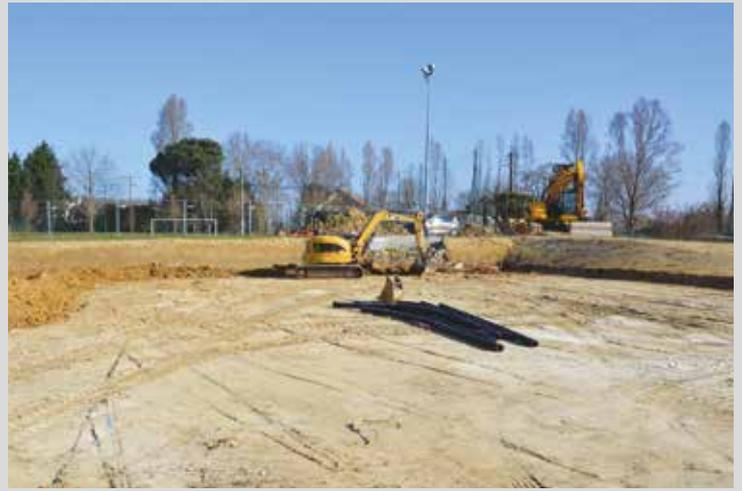
Retardés par les intempéries, les travaux de construction du tennis couvert avancent à présent. La plateforme est dégagée et elle sera stabilisée par un traitement dans les jours qui viennent et complétée par l'empierrement et plus tard par la pose de l'enrobé définitif.
