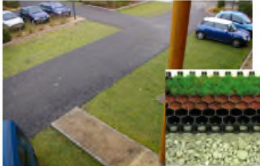
parking dalles alvéolaires enherbées
