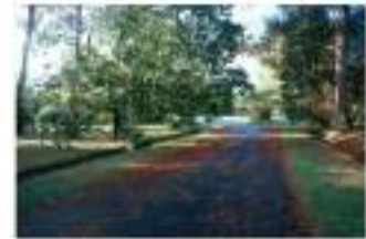
voirie et fossés latéraux
