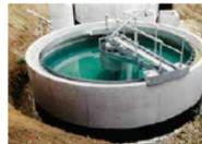
L'élimination de cette pollution crée des boues qui sont séparées de l'eau ainsi traitée dans un ouvrage spécifique appelé clarificateur. L'eau y transite à vitesse très lente. Alors que les boues décanteront et se déposeront au fond de l'ouvrage, l'eau débarrassée de ces boues est évacuée vers la zone humide. Les boues ainsi séparées sont épaissies, stockées dans un ouvrage, puis évacuées.
