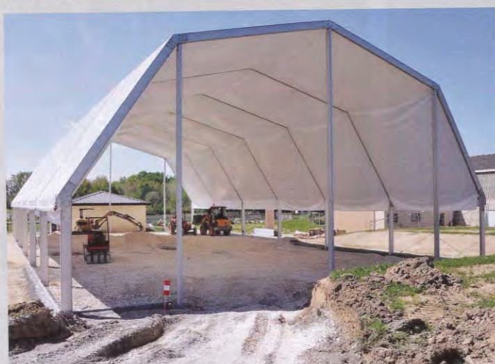
Tennis couvert, l'avancée des travaux.
